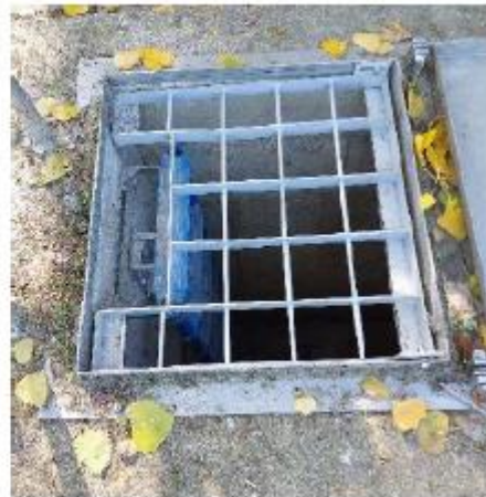
Fig. 5: met uitsparing voor valbeveiligingspaal
