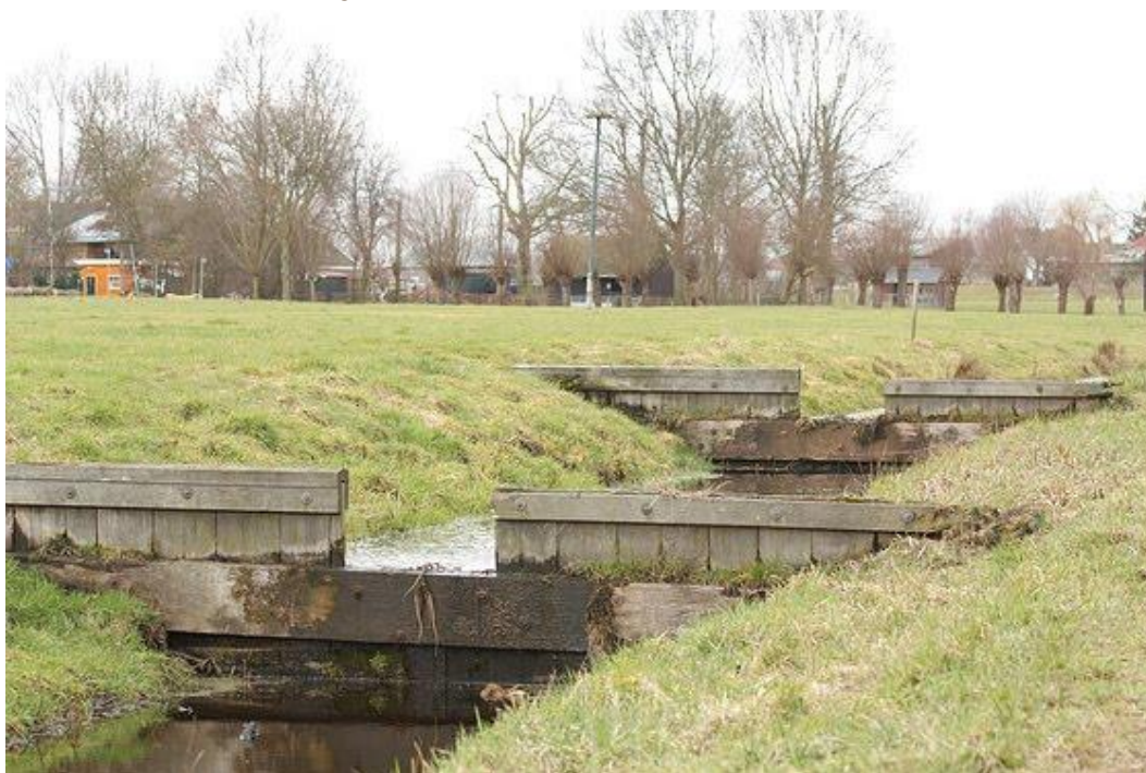
Foto: Schotten in grachten vermijden dat al het water wegstroomt en zorgen voor voldoende infiltratie.
