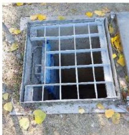
Fig. 5: met uitsparing voor valbeveiligingspaal
