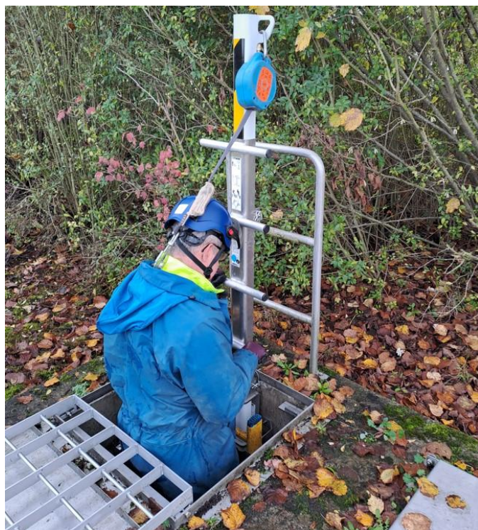
Fig. 9: Mobile verankeringspaal tbv valbeveiligingssysteem 2:
