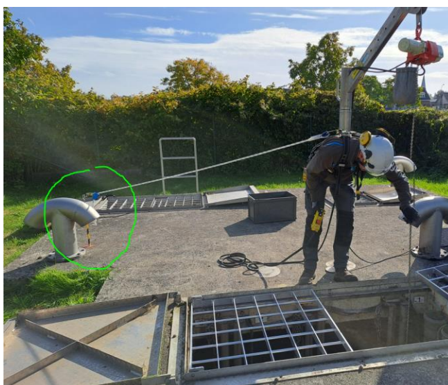
Fig. 7. Valbeveiligingssysteem 1 met betonnen funderingssokkel:
