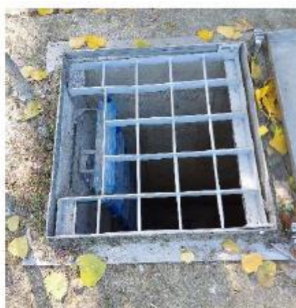
Fig. 5: met uitsparing voor valbeveiligingspaal
