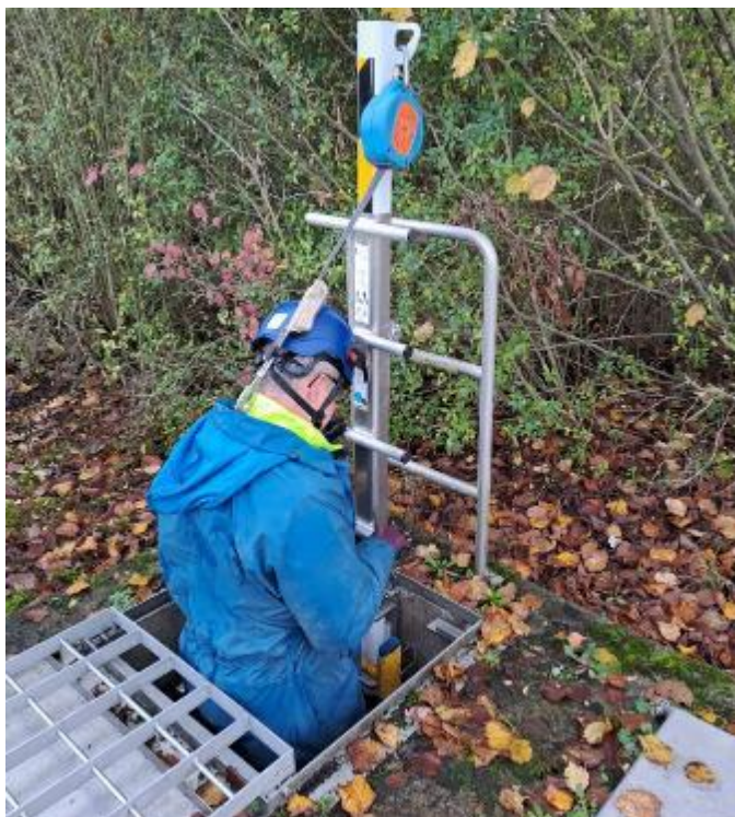
Fig. 9: Mobiele verankeringspaal tbv valbeveiligingssysteem 2:
